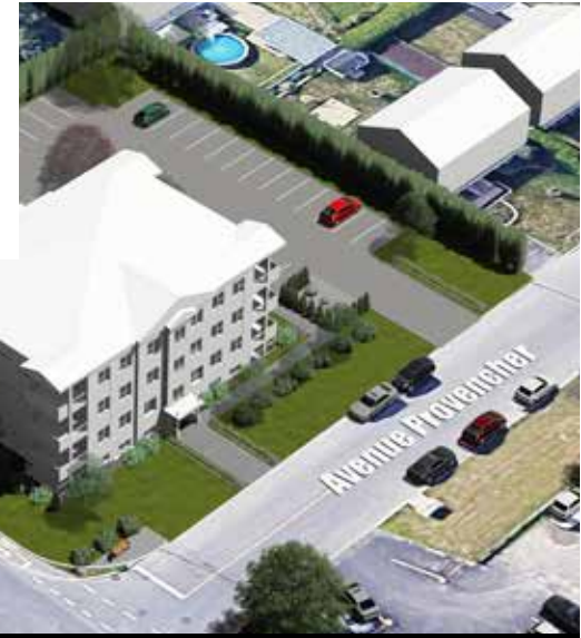
Projet de développement résidentiel situé au 305, montée Sanche, à l'angle de l'avenue Provencher.
